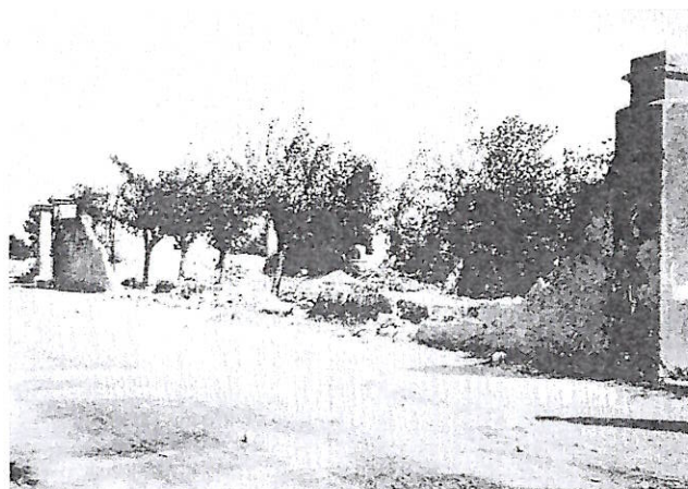
Fig. 2 - Domanins. Muro di cinta del Palazzo Conte di Spilimbergo.
