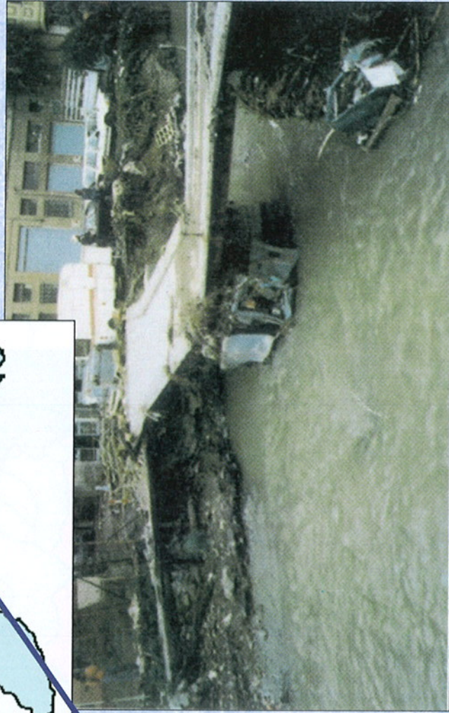
TORRENTE STURLA: ponte carrabile presso la foce danneggiato dall'evento e successivamente demolito.
